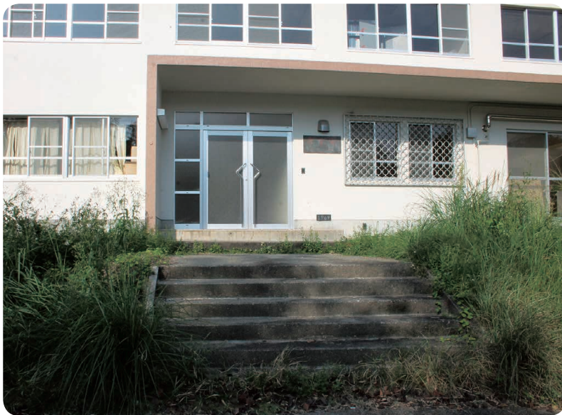
車道用スロープに改修される旧愛宕寮玄関（高池）
